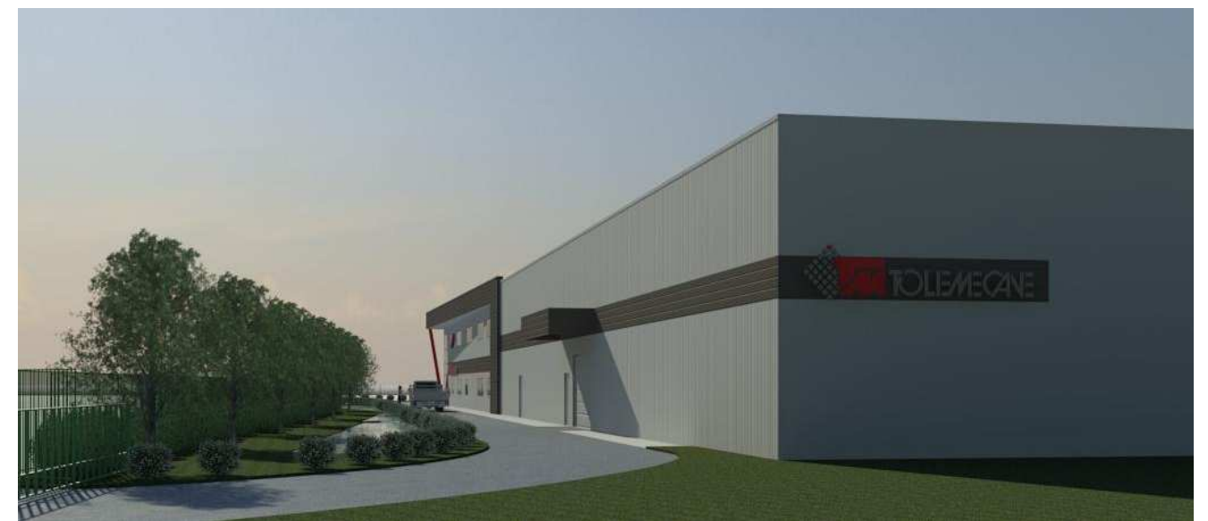
Vue depuis l'accès des camionnettes
